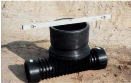
1. Лотковая часть горизонтально укладывается на 5-10 см слой неуплотненной песчаной подсыпки, представляющей собой выравнивающий слой дна котлована. Для подсыпки и засыпки мы можем использовать местный грунт при условии соблюдения требований, выдвигаемых в отношении песчаных подсыпок и обсыпок. При выравнивании лотковой части необходимо помнить о встроенном уклоне дна, равном 1,5%. В пропускных основаниях стрелка показывает правильное направление течения сточных вод.
