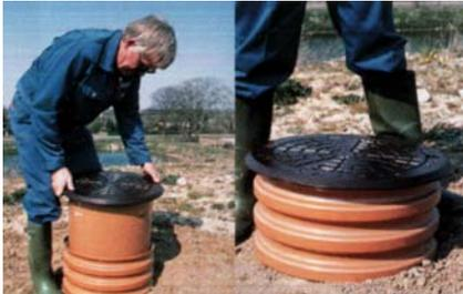
7. Уплотнительное кольцо смазать силиконовой смазкой и установить люк. Установить положение верха люка или дождеприёмника соответственно отметки на местности.
