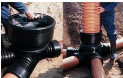
4. Раструб лотковой части необходимо очистить от загрязнений и смазать силиконовой смазкой. Установить шахтную трубу в раструбе днища колодца посредством вдавливания. Выполненное соединение является герметичным. Заглушку, вынутую из раструба днища колодца, необходимо установить наверху гофрированной трубы с целью предохранения сооружаемой канализационной сети от загрязнений в ходе последующей сборки.
