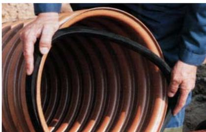
3. Уплотнительное кольцо гофрированной трубы необходимо поместить в самом нижнем желобке снаружи шахтной трубы.
