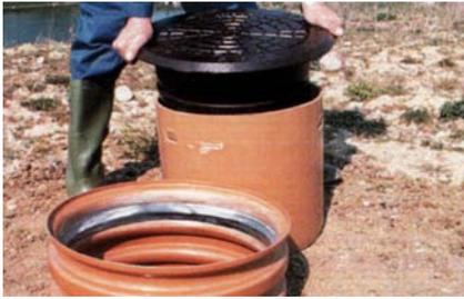
6. В случае применения чугунных люков с телескопическим адаптером, поставляемое вместе с ними уплотнительное резиновое кольцо (для гофрированной трубы) необходимо установить в наиболее высоко расположенном желобке внутри гофрированной трубы. Выполнить соединения люка или дождеприёмника с телескопической трубой (механическое соединение на защёлку).
