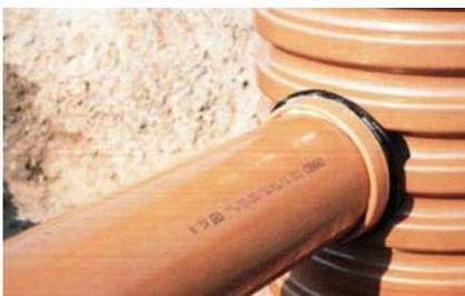
3. Установленная таким образом муфта готова для помещения в неё гладкостенной канализационной трубы из ПВХ.
