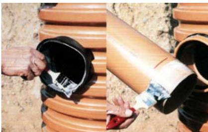
2. Установить в высверленном отверстии специальную прокладку и смазать её силиконовой смазкой. В отверстие, подготовленное таким образом, необходимо установить специальный раструб муфты.
